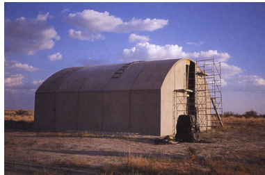
Abbildung 4.3: D. Judd; Betongebäude; 1980
